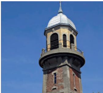
1. La tour des dockers au Havre
